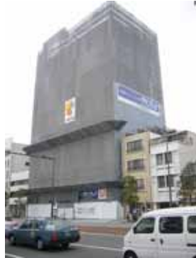
工事現況(外観)
